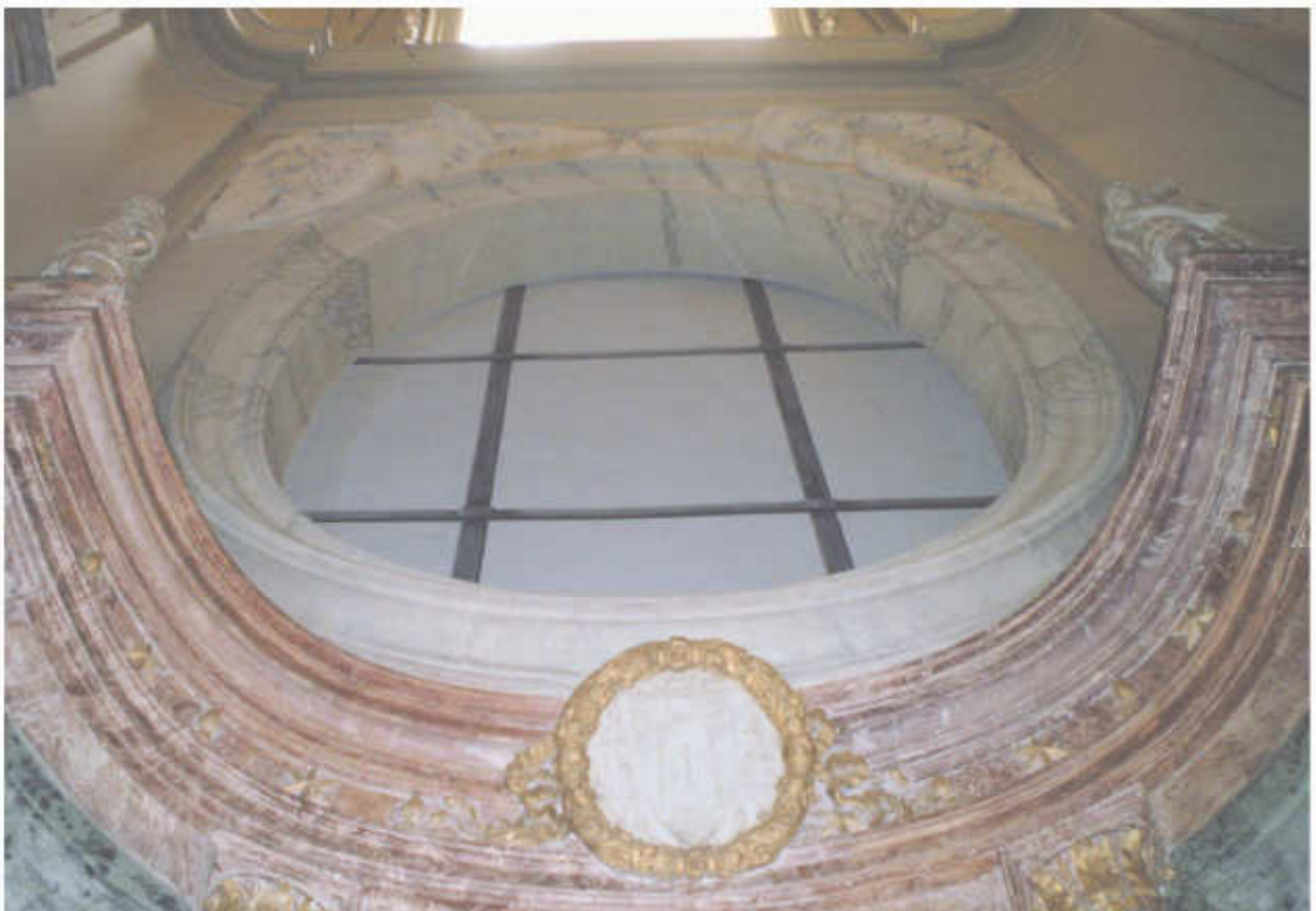
Fig. 7_ La trabeazione deformata in funzione della sua finestra ovale corrispondente.
