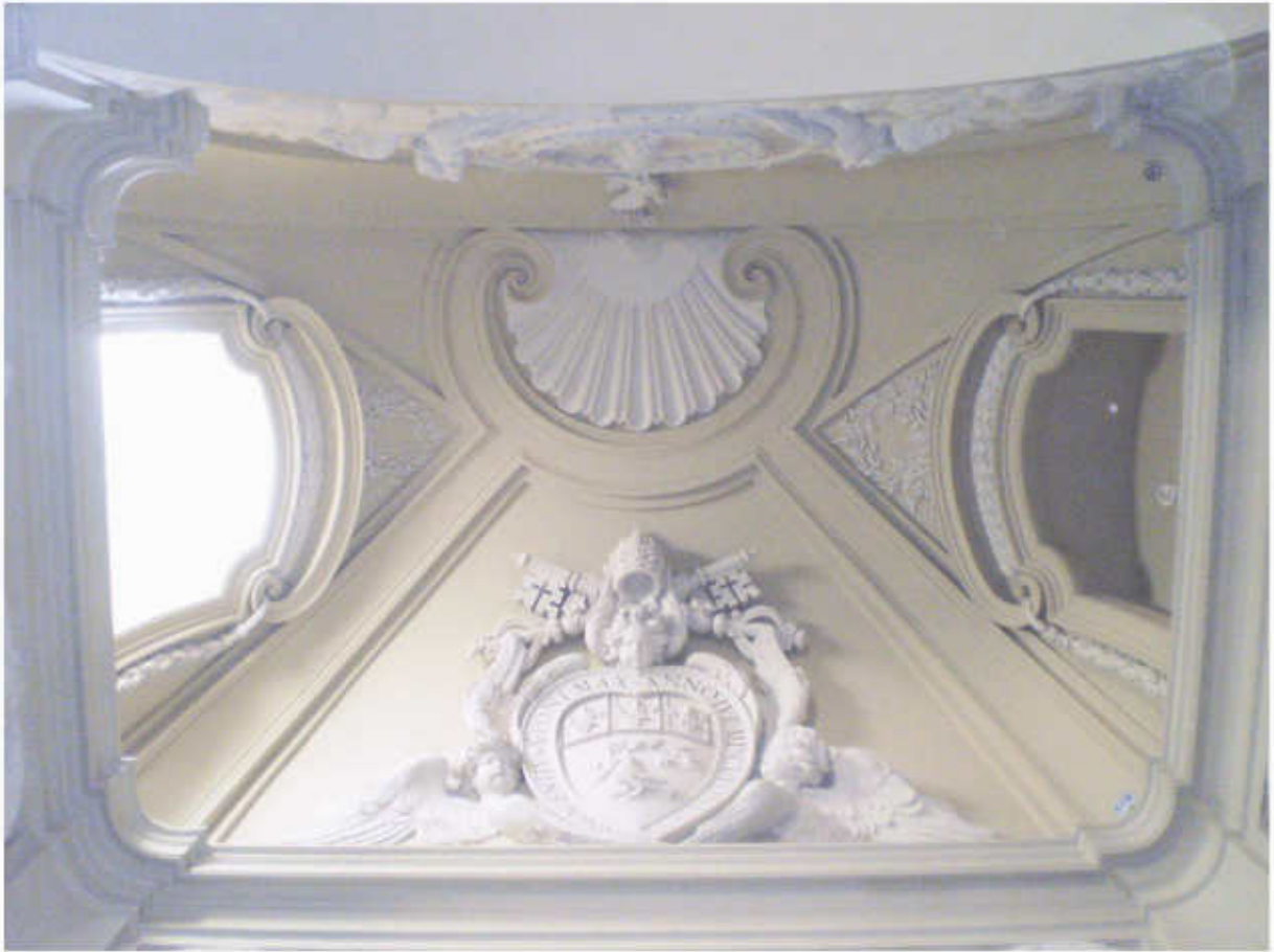
Fig. 5_ F. Borromini. Camera di luce realizzata nella volta che si trova al di sopra del monumento De Chaves.
