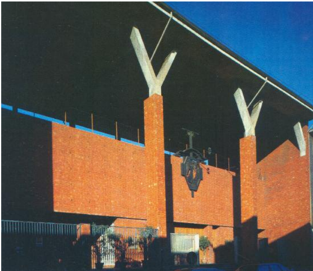
A. CASTIGLIONI, P. CASTIGLIONI, San Gabriele Arcangelo in Mater Dei , Milano, 1957. Prospetto principale
