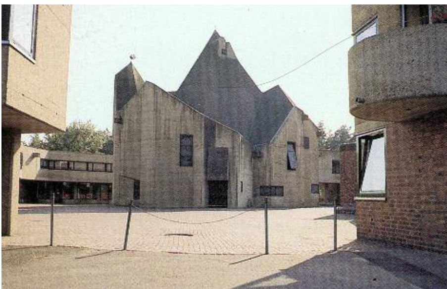
Sopra: GOTTFRIED BÖHM, S. Giovanni , Rheda, 1961-65. Esterno
