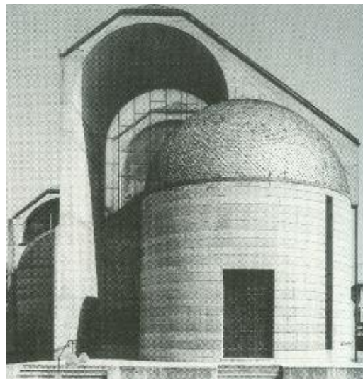
E. CASTIGLIONI, Santi Nazario e Celso , Gorla minore, Prospiano, Varese, 1962. Destra: prospetto principale. Sinistra: prospetto posteriore
