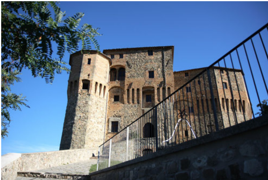
Veduta del fronte principale
