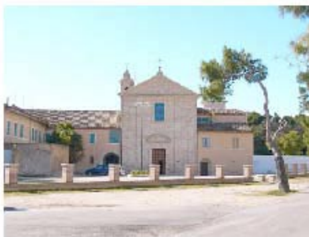
Figura 25 - Grottammare. Oasi di Santa Maria ai Monti. Facciata (foto Biocca).
