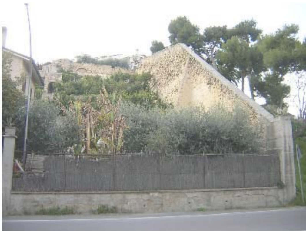
Figura 19 - Grottoammare. Mura nei pressi della Strada Statale n. 16 (foto Corona).
