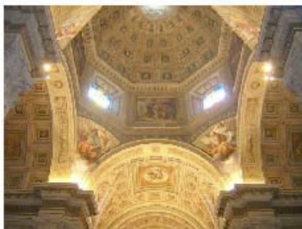
Figura 140 - Montalto Marche. Santa Maria Assunta. Chiesa superiore. Particolare delle trombe e della cupola (foto Corona).
