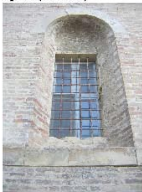
Figura 113 - Grottammare. Chiesa di Santa Lucia. Facciata. Monofora (foto Corona).
