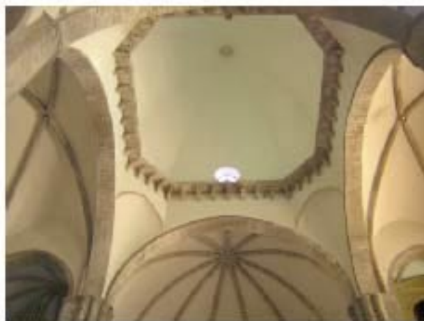
Figura 129 - Ascoli Piceno. Chiesa di San Francesco. Interno. Particolare dei pilastri angolari e della cupola (foto Corona).
