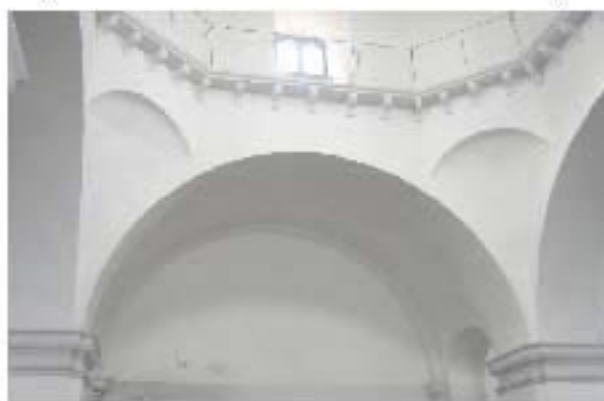
Figura 97 - Grottammare. Chiesa di Santa Lucia. Particolare delle trombe d'angolo (foto Corona).
