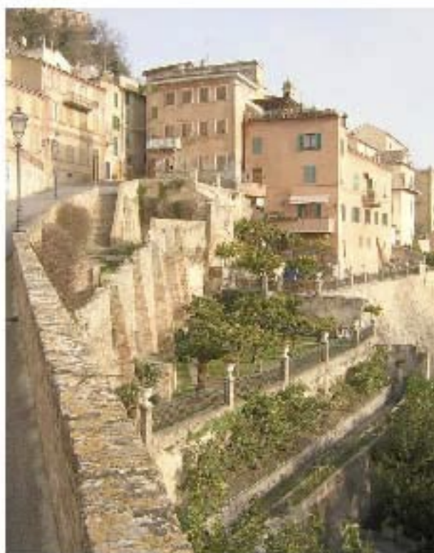
Figura 79 - Grottammare. Centro storico. Mura di sostegno in via Palmaroli (foto Corona).
