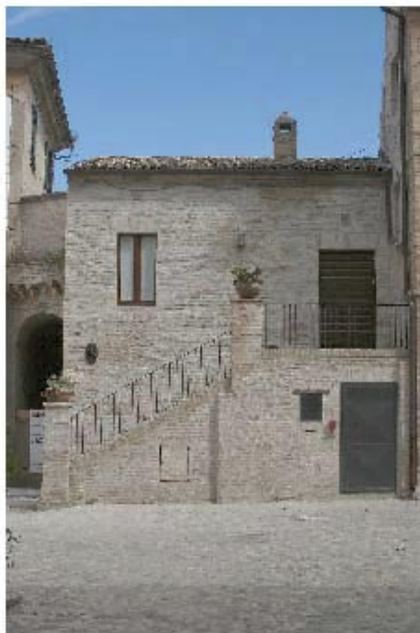
Figura 78 - Grottoammare. Centro storico. Ex palazzo comunale (foto Corona).
