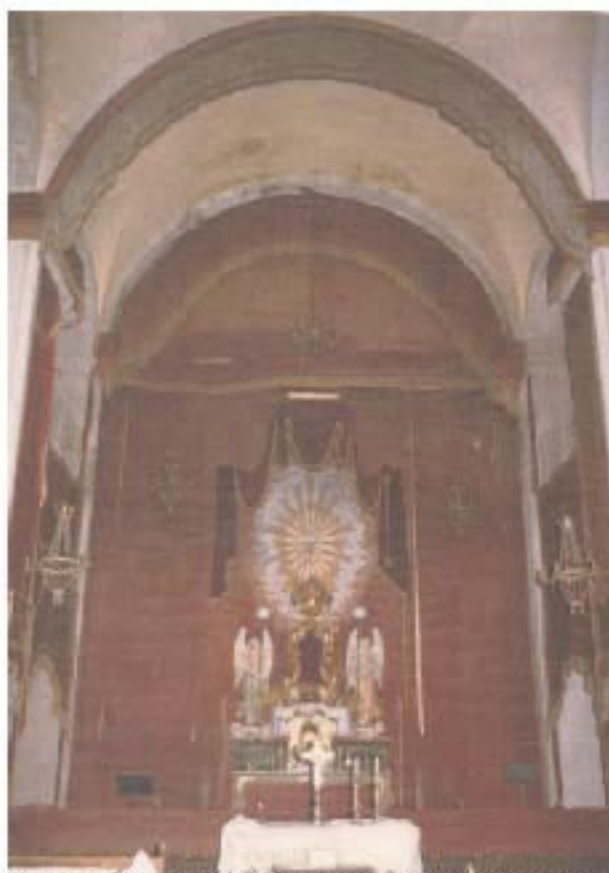
Figura 133 - Grottammare. Chiesa di Santa Lucia. Arredo interno prima del restauro del 1988 (da Archivio storico della Soprintendenza per i Beni Architettonici e Paesaggistici delle Marche, AP 120).
