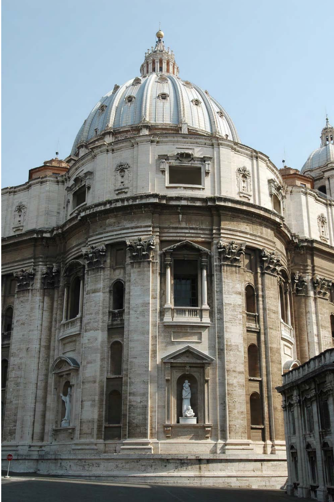
11. Vista dell'esterno della cappella del Re.
