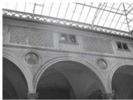
Particolare dell'attacco della copertura
