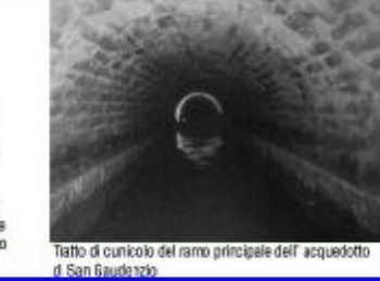
Galleria con volta a botte larga 0,7 m e alta 1,5 m
