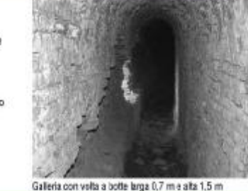
Galleria con volta a botte larga 0,7 m e alta 1,5 m
