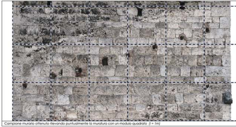
Campione murario ottenuto rilevando puntualmente la muratura con un modulo quadrato (l = 1m)
