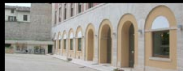
ILLUMINAZIONE ESISTENTE (vista diurna)
