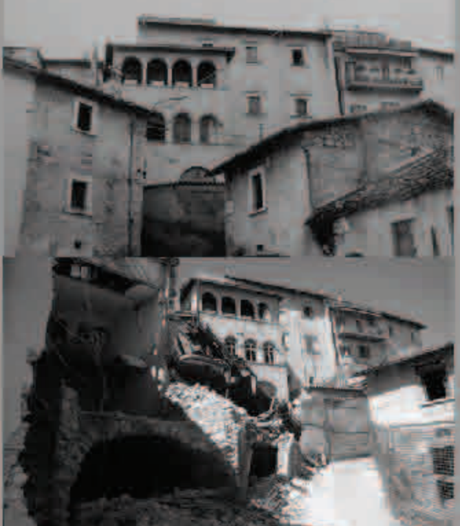
PALAZZO VICENTINI ED EDIFICI CIRCONDANTI
