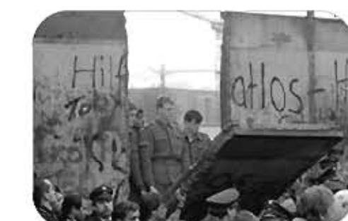
1989 CROLLO DEL MURO
