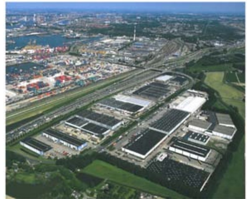
Distripark Eemhaven prima e dopo la costruzione.
