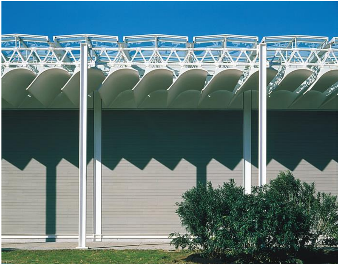
Dettaglio esterno della copertura
