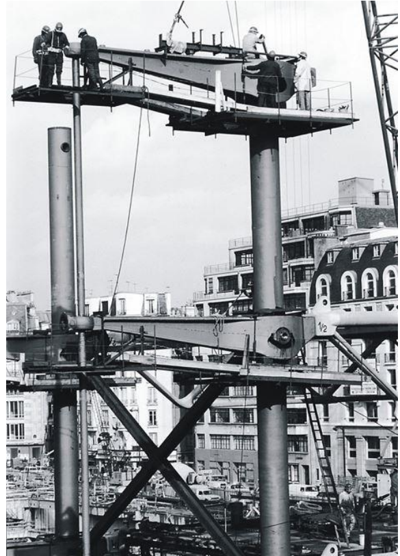
Le travi Gerber in fabbrica e in cantiere
