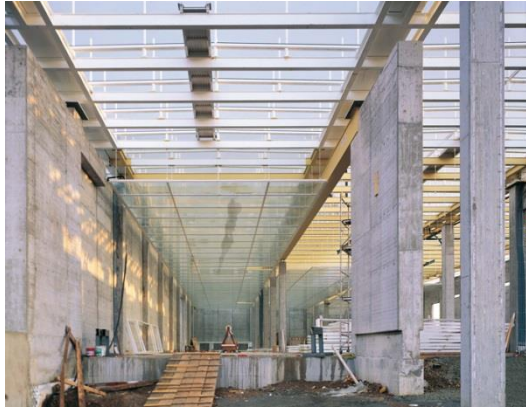
Fase di cantiere: la “doppia copertura”
