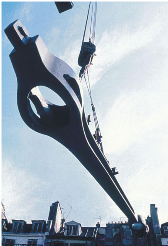
Le travi Gerber in fabbrica e in cantiere
