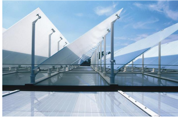
Dettaglio del sistema di filtrazione della luce
