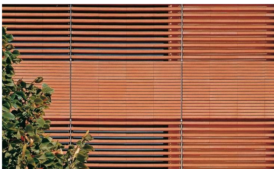
Banca Popolare di Lodi, dettaglio facciata
