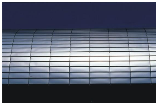
Aeroporto internazionale di Kansai (1988), dettaglio di copertura
