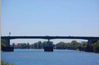
PIONEER MEMORIAL BRIDGE (1971) Lunghezza 263 m Sacramento
