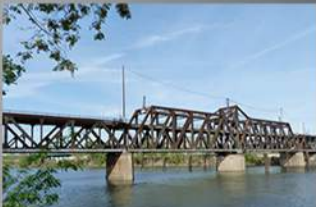
I STREET BRIDGE (1911) Lunghezza 255 m Sacramento
