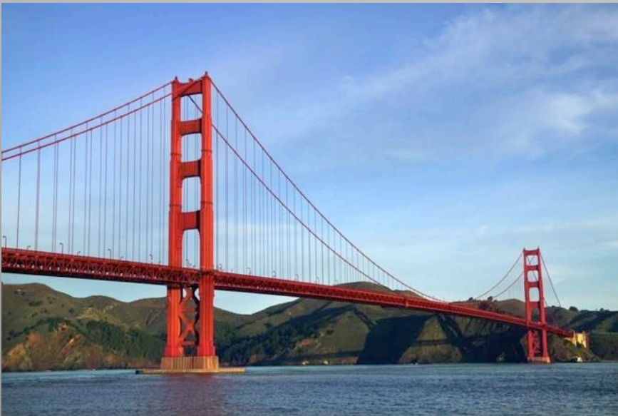
GOLDEN GATE BRIDGE (1937) San Francisco Lunghezza 2737 metri
