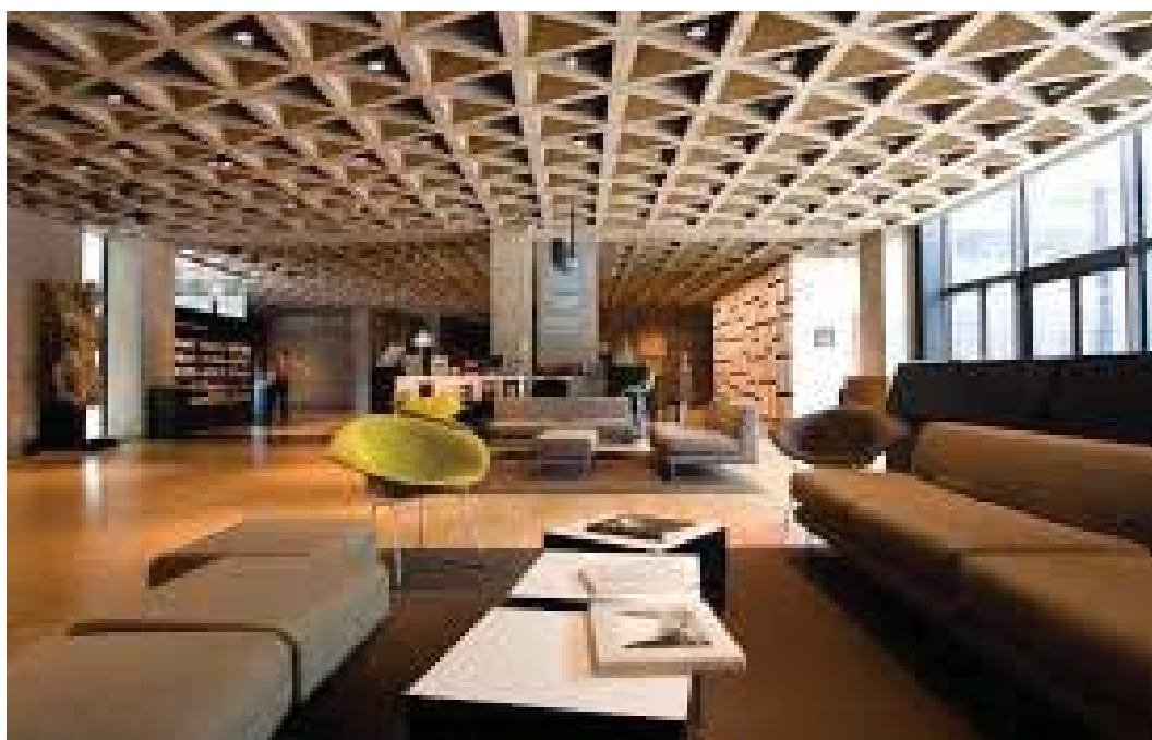
Louis I. Kahn, intradosso di uno dei solai di Yale Art Gallery di New Haven Connecticut
