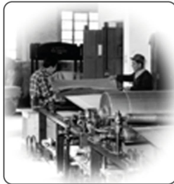
La foto d'epoca, proiettata sul pavimento, mostra ciò che avviene alla fine della macchina, quando il nastro di carta prodotto viene tagliato ed i fogli impilati. Parte della proiezione prende un bancale d'epoca poggiato a terra.
