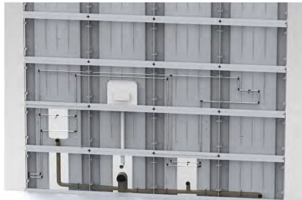
3 MONTAGGIO TUBI DI ADDUZIONE DELL'ACQUA
