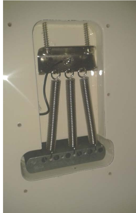
Vista inferiore di un ponte mobile (lato molle)
