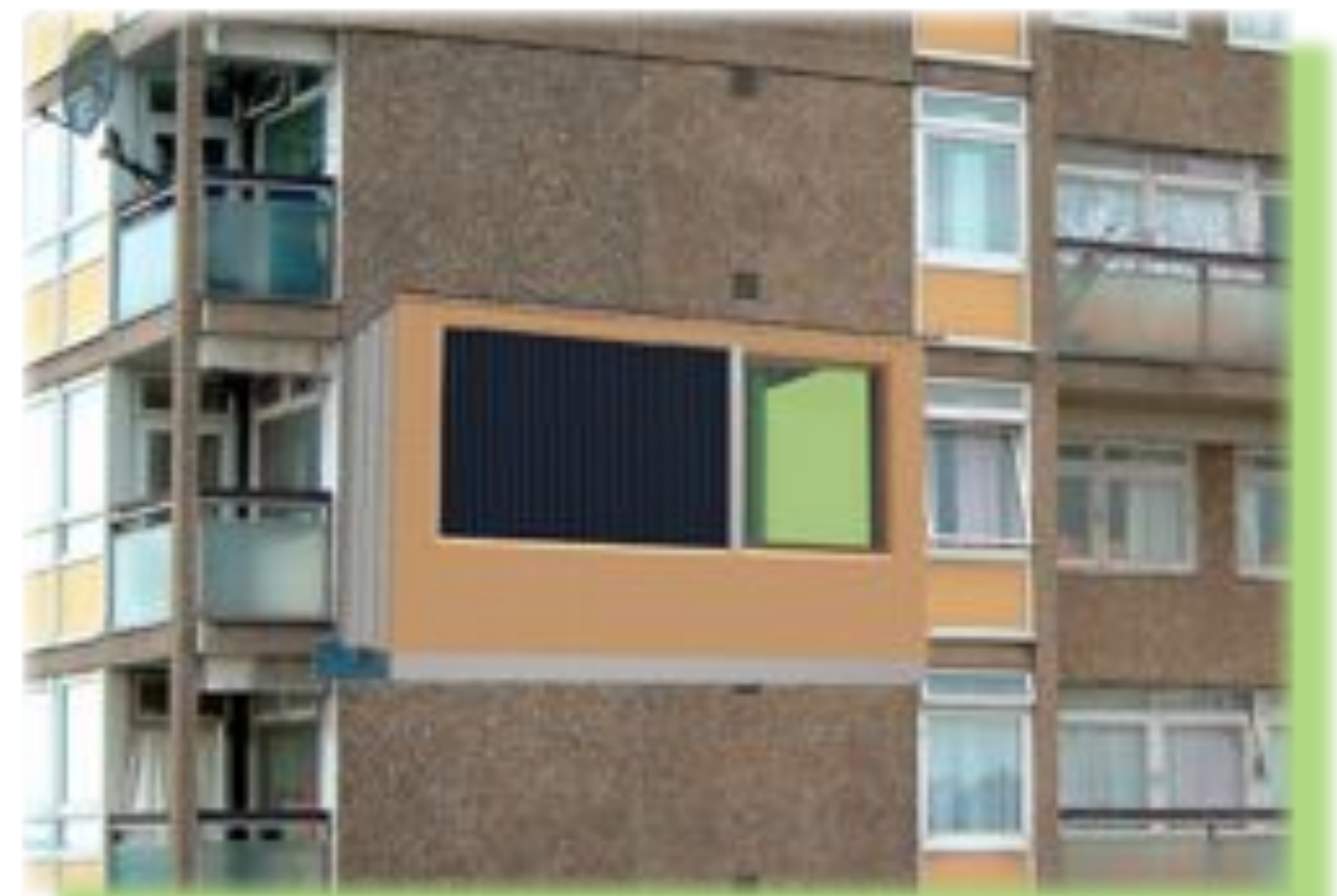
INSTALLAZIONE DI EXPANDER SU UN EDIFICIO DEGLI ANNI 80
