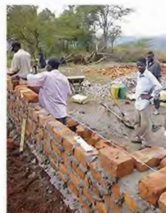
Dettaglio struttura chiusura verticale in mattoni adobe
