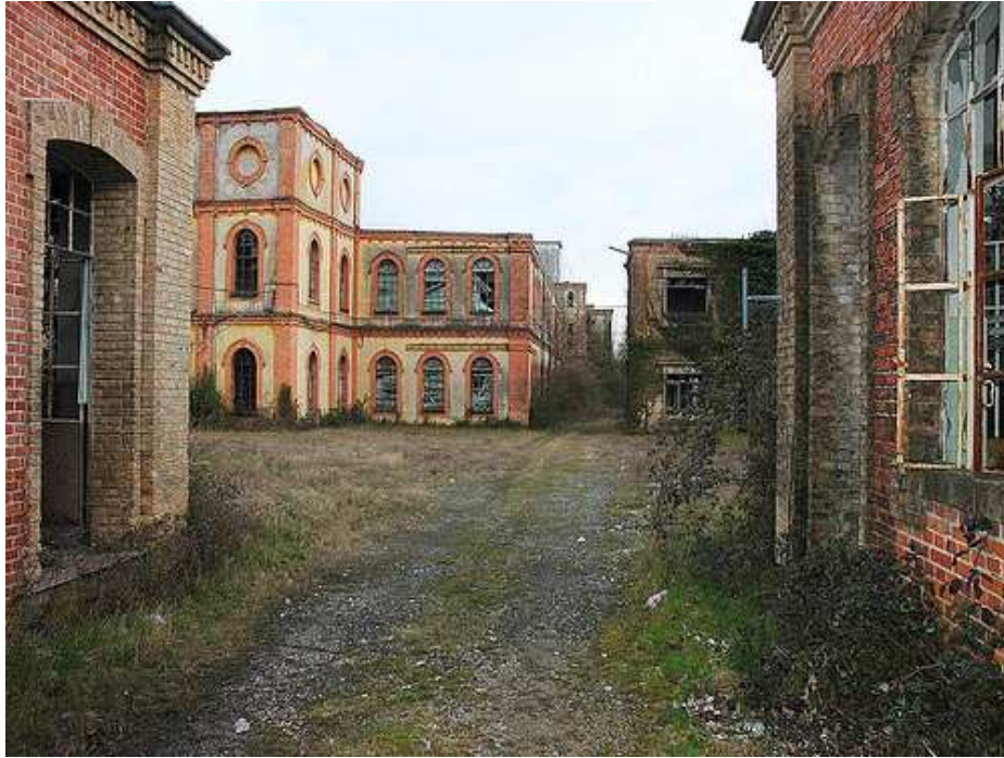
13. Interno Stabilimento di Papigno -1989
