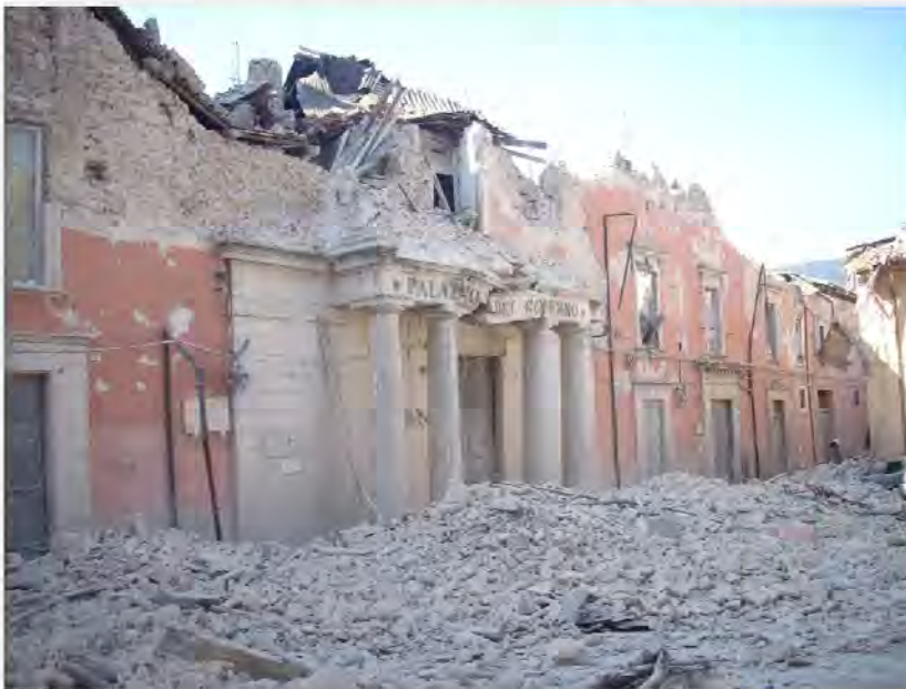
Sede della Prefettura de L'Aquila distrutta dal terremoto
