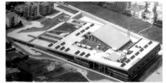
VISTA AREA PRIMA INTERVENTO
