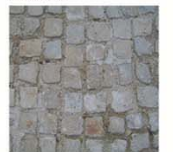
4 Pavimentazione in selci di pietra squadrate, orditura orizzontale, dimensione media cm 9,7 x 8,8
