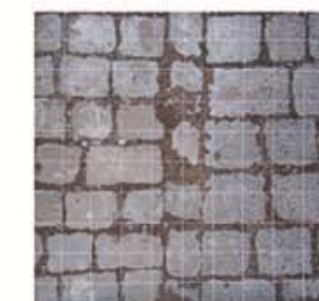
3 Pavimentazione in selci di pietra squadrate, orditura orizzontale, dimensione media cm 14,6 x 15,8
