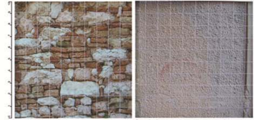
Muratura composta da conci di pietra calcarea irregolari e mattoni di diverse dimensioni e cottura.
