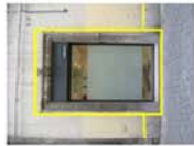
Apertura, rifiniture con cornice
