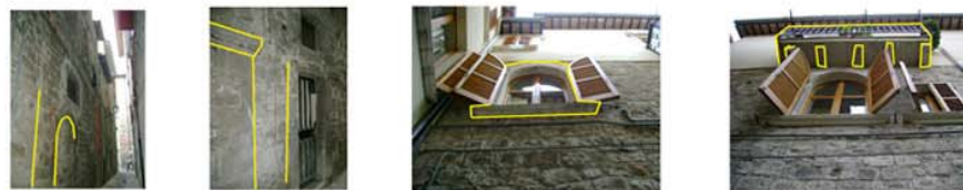
Presenza di arcate occulte e differenza di murature Presenza di aperture con cornici occulte Aerture con cornici Presenza di balconi poggiati su mensole in pietra
