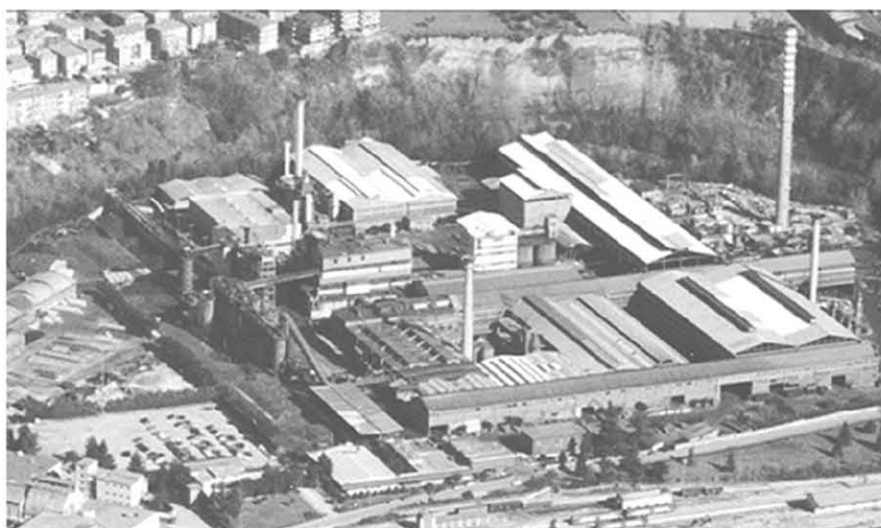
Vista generale area SGL-Carbon
