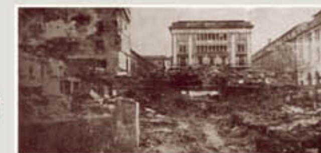
Apertura di corso Salaria. Demolizione degli ultimi fabbricati verso piazza Roma.
