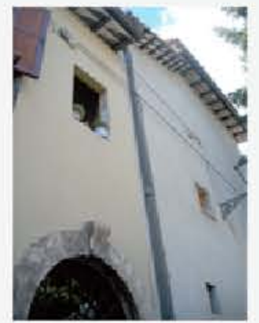
9. Particolare di un'area dell'isolato e delle strutture della torre dove si opera.
