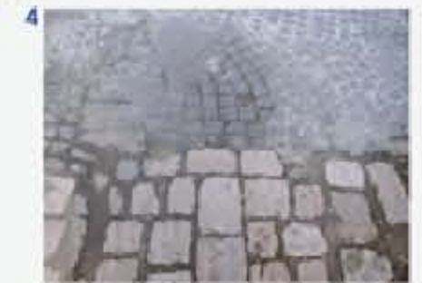
1. PAVIMENTAZIONE IN SANPIETRO: le pavimentazioni più recenti, sono in blocchi di selce a forma di rombo, in un primo tempo a cubo e poi a quadrato, posati e reggiti su un fondo di cemento.
