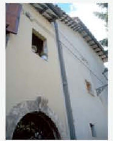
9. Veduta di strada, si nota la copertura in tegole rosse.
