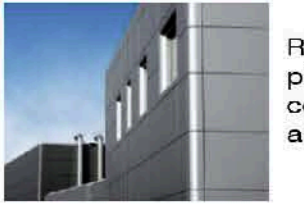
Rivestimento piano superiore con pannelli d'alluminio
