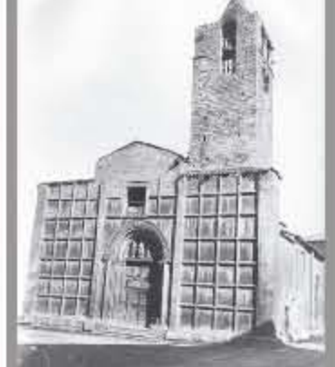
SS. Vincenzo e Anastasio. Campanile originale successivamente demolito per problemi statici. 1882
