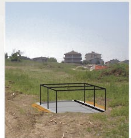
- montaggio struttura in acciaio
