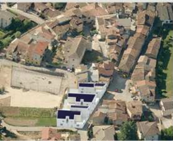
Vista aerea lato nord
