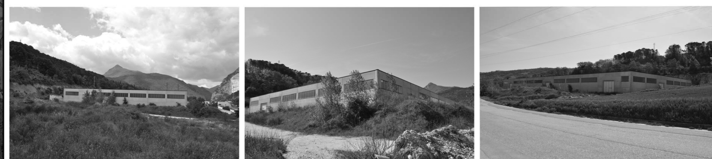
foto Capannone oggetto d'intervento
