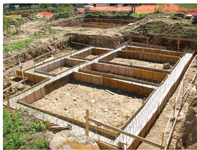
FONDAZIONI IN CEMENTO ARMATO
