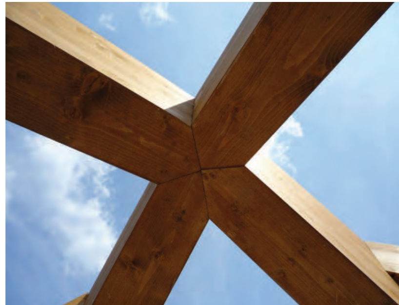
INTELAIATURA IN LEGNO DELLA COPERTURA
