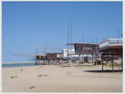
trabocchi insabbiati dalla diga
