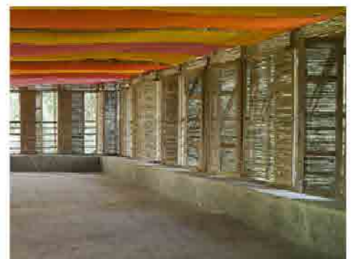
STRUTTURA PORTANTE IN LEGNO E TAMPONATURA IN SACCHI DI JUTA
