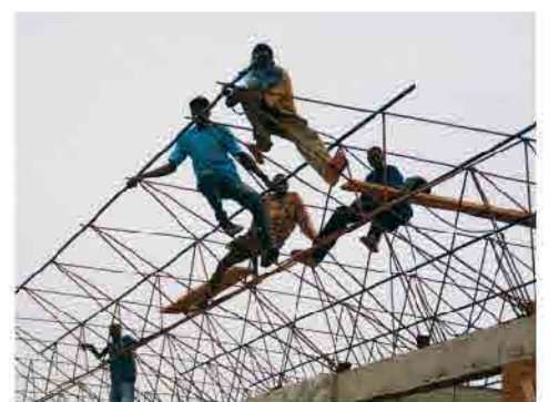
COPERTURA IN LAMIERA ONDULATA E TRAVI RETICOLARI
