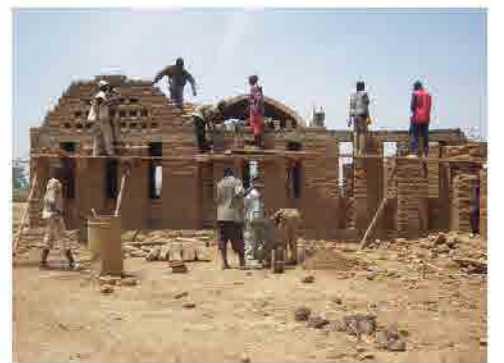
STRUTTURA PORTANTE IN MATTONI IN TERRA CRUDA
