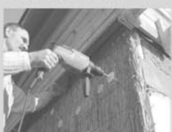
TAMPONATURA IN BAMBÙ
