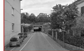
SOTTOPASSAGGI: INADEGUATO AL TRANSITO PEDONALE
