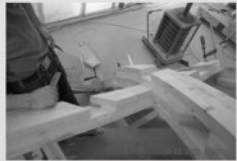
ASSEMBLAGGIO E FISSAGGIO DELLA STRUTTURA PREFABBRICATA
