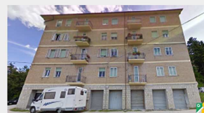
edificio ai limiti della zona rossa
