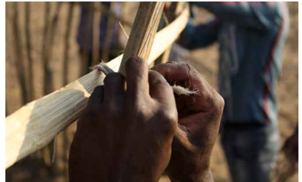
Sopra: copertura installazione con stoffe del vicino mercato di Mapusa, 11 . 01 . 2015. Sotto: Ranjit alle prese con le legature della struttura in bamboo, 09 . 01 . 2015.
