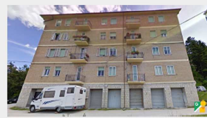
edificio ai limiti della zona rossa
