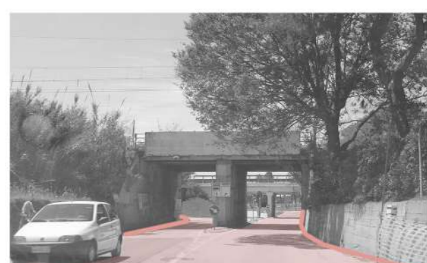
La strada che connette l'area periferica dove si trova l'Hotel House con la città, è priva di marciapiede
