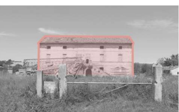
Casa rurale in disuso immersa nella zona agricola che circonda l'Hotel House contribuisce allo stato di isolamento e degrado della area
