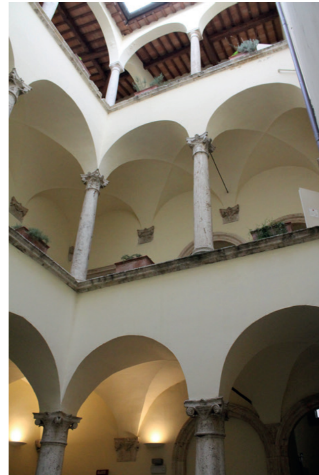
fig. 43 Il cortile chiuso.
