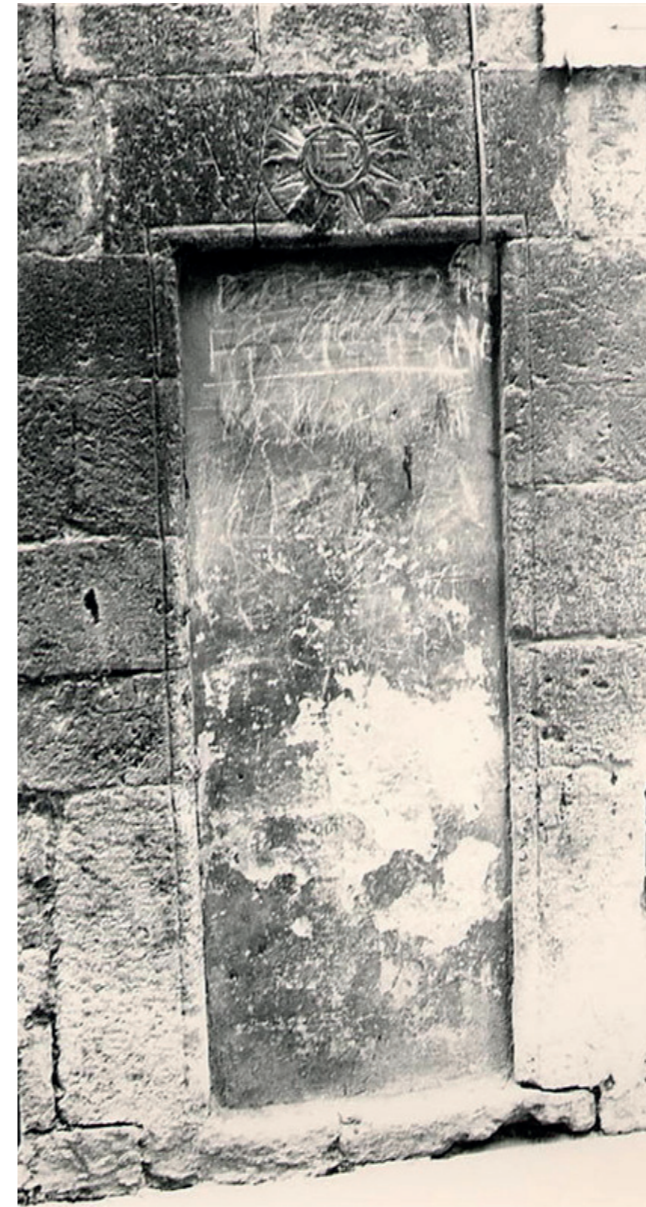
fig. 5 La porticina murata visibile sul fronte di via Alvitreti, misura 0,65 m x 1,77 m.
