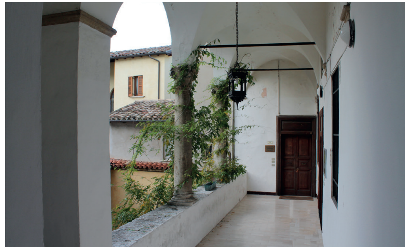
Foto della loggia al piano nobile.
