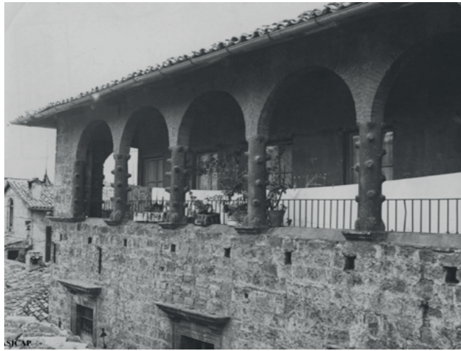
fig. 49 Il loggiato al terzo piano in una fotografia del 1969.
