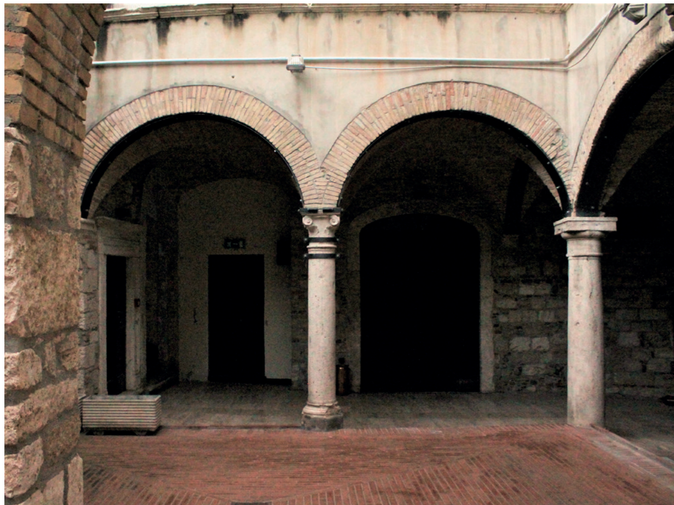
fig. 72 Cortile Ovest. Si notano le due colonne diverse, una con capitelo composito, l'altro con capitello dorico.
