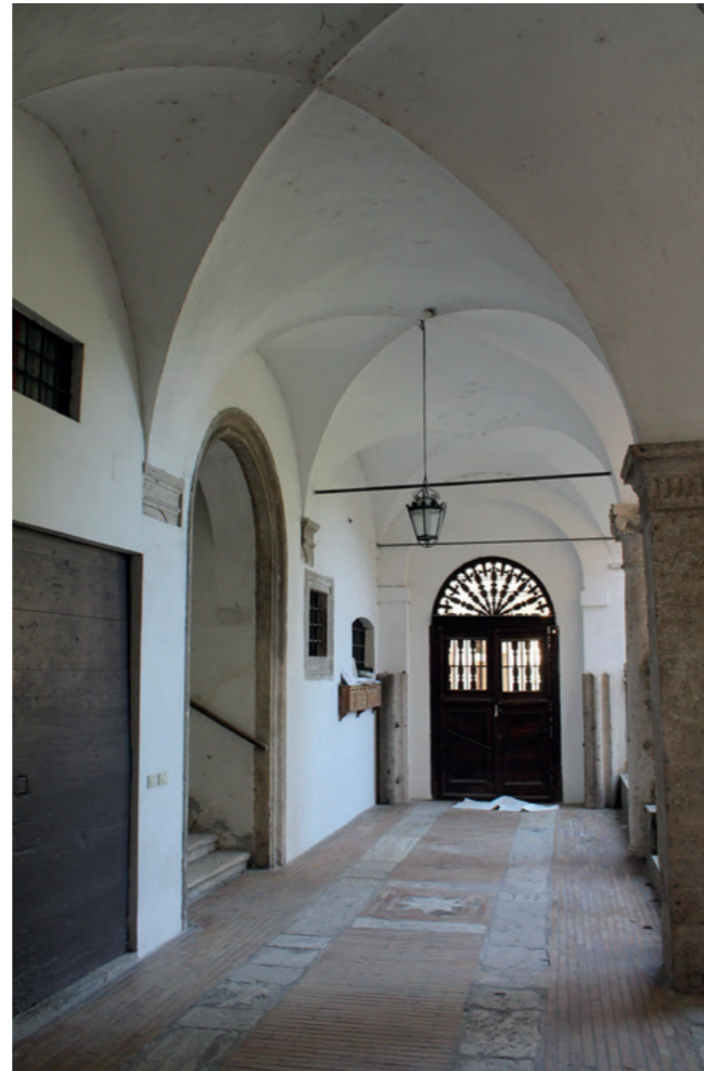
fig. 53 L'accesso allo scalone.
