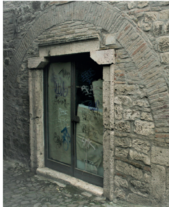
fig. 14 Tracce di elementi di epoche diverse: conci di diverse dimensioni ed arco in laterizio.
