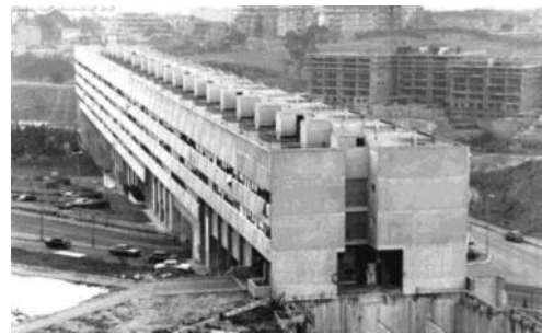
Fig.re 20 il Cantiere
