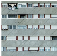
FRONTI PRINCIPALI: pannelli in cls a motivi diagonali di sp. 8 cm e serramenti a nastro in pvc
