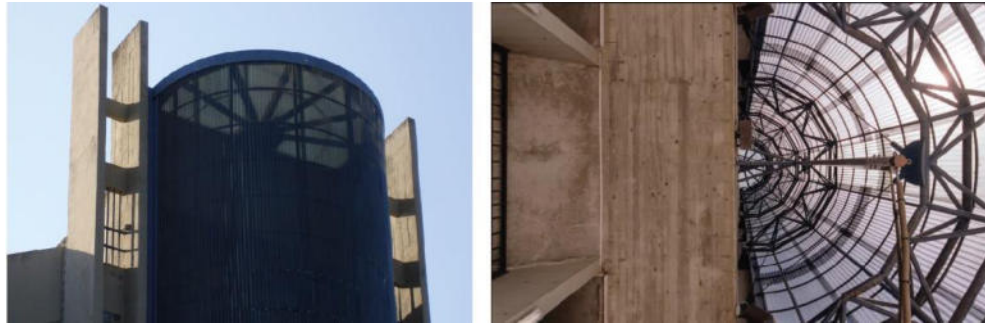
Fig.re Dettaglio del supporto e del rivestimento del corpo scala monumentale
