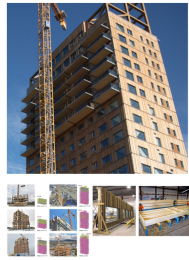
Mjosa Tower (Norvegia) è l'edificio in legno lamellare più alto al mondo. Esso presenta una struttura a telaio in legno. I solai e le pareti di tamponamento prefabbricati giungono in sito pronti per il fissaggio alla struttura stessa.
