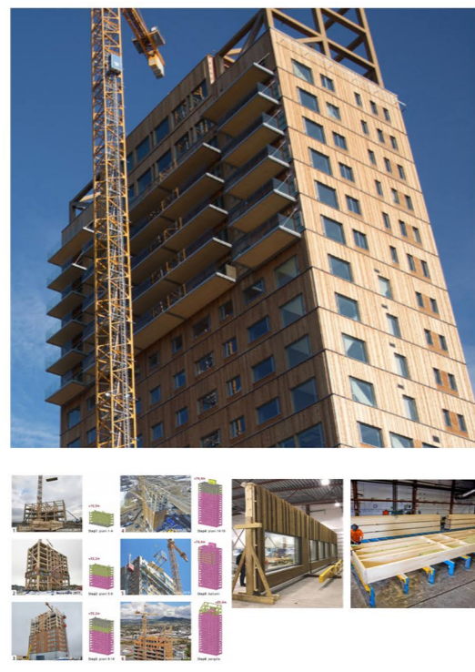
Mjøsa Tower (Norvegia) è l'edificio in legno lamellare più alto al mondo. Esso presenta una struttura a telaio in legno. I solai e le pareti di tamponamento prefabbricati giungono in sito pronti per il fissaggio alla struttura stessa.
