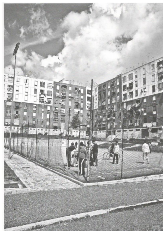
Selva Cafaro, quartiere ubicato a San Pietro a Paterno (periferia nord di Napoli); viene realizzato alla metà degli anni ottanta con procedimenti di prefabbricazione industriale (acciaio e calcestruzzo armato).
