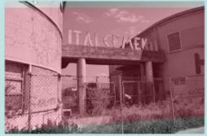
2. Area sud ex Ital-Cementi in stato di abbandono e degrado
